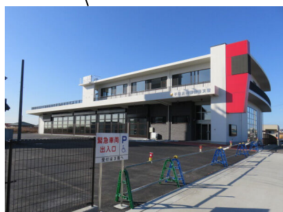
半田消防署武豊支署
