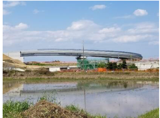
整備が進められている武豊北IC
