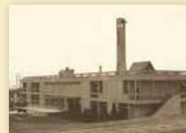
昭和 39 年 武豊町役場（移設後）
