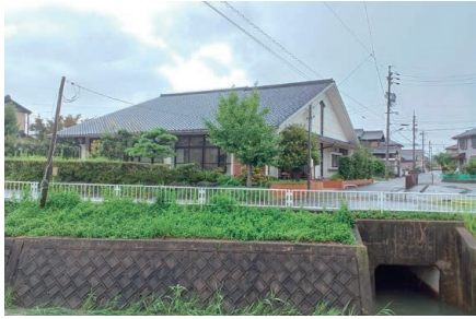
▲太陽光発電設備の導入予定施設
