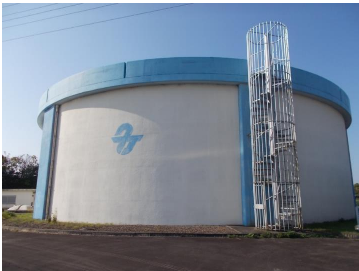
武豊第 2 配水池
