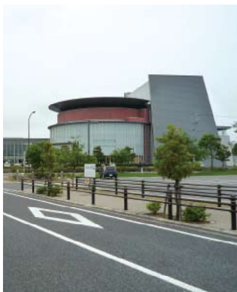
■改修や統廃合を検討する公共施設
