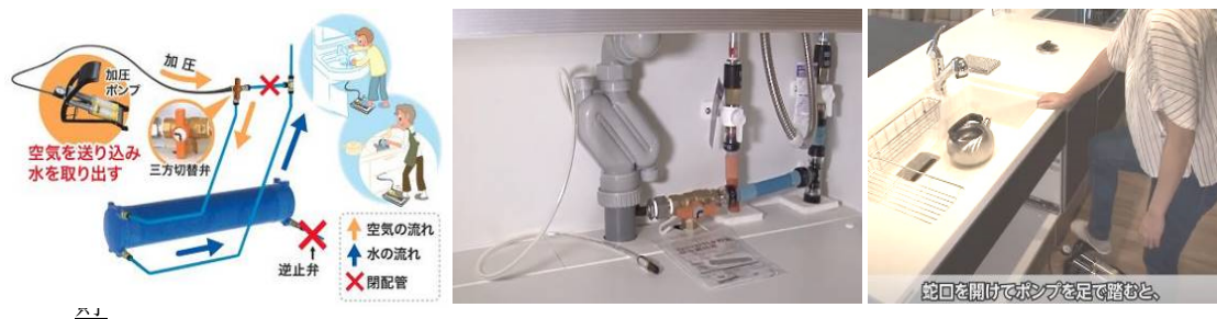
水槽周り配管の一例 流し台下部の操作弁及び足踏みポンプ〔メーカーHPより〕
