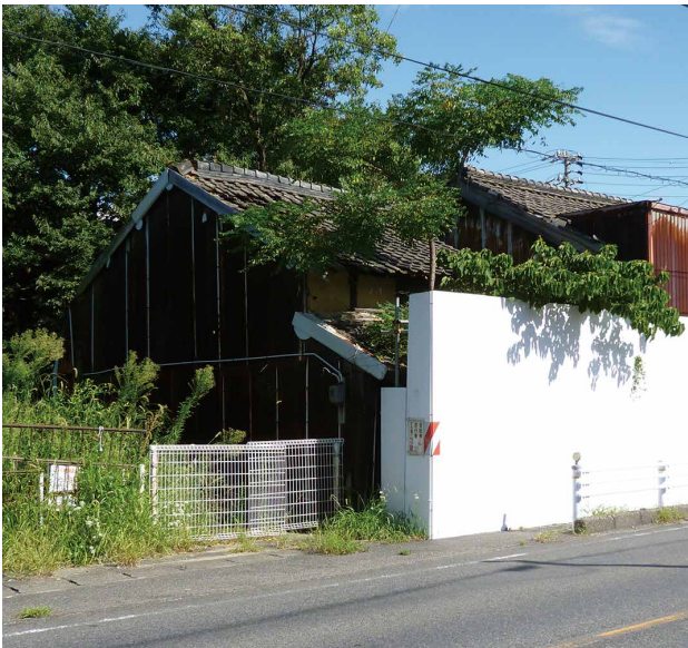
▲ 危険な空き家
