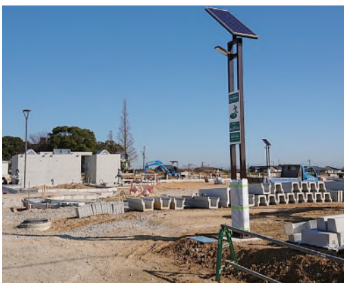
▲ 武豊中央公園の工事風景
