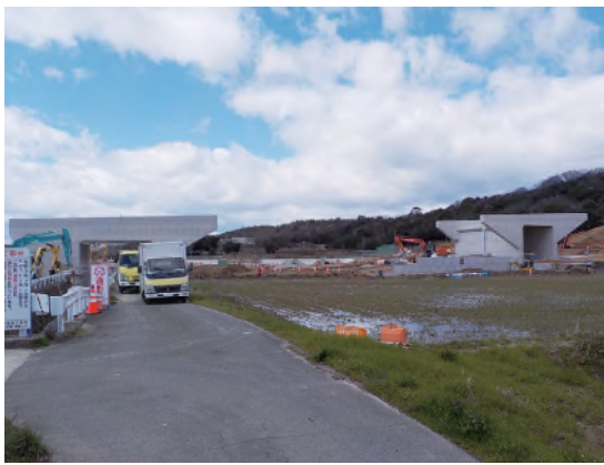
▲ 工事の進む（仮称）武豊北インターチェンジ
