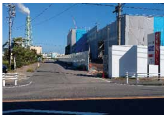
▲国道 247 号から車両通行不可になる町道
