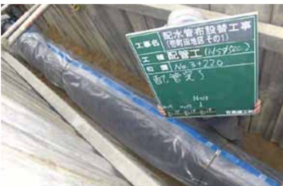
▲重要給水施設管路耐震化工事
