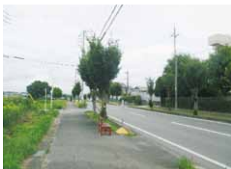
▲防護柵を設置する六貫山線（緑丘小学校前）
