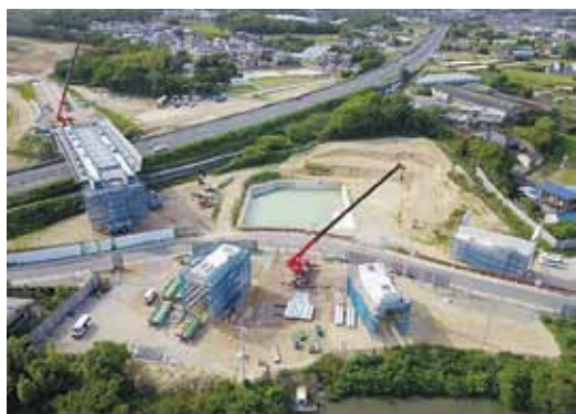
▲武豊北インターチェンジ周辺
