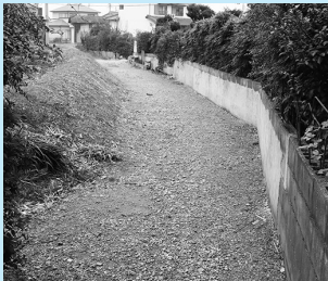
▲砕石を敷いた道路
