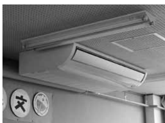
▲設置されたエアコン
