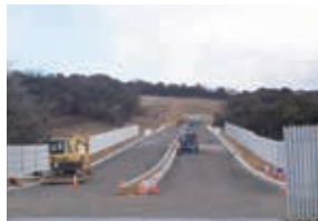
▲インターチェンジ入口施工の様子
