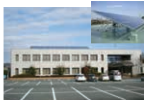
▲保健センター屋上の太陽光パネル
