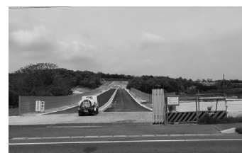
▲武豊北 IC (仮称) 入口の施工の様子
