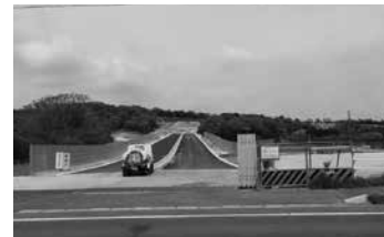
▲武豊北 IC (仮称) 入口の施工の様子
