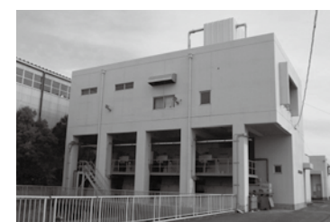
▲雨水ポンプ場（雨水排水施設）
