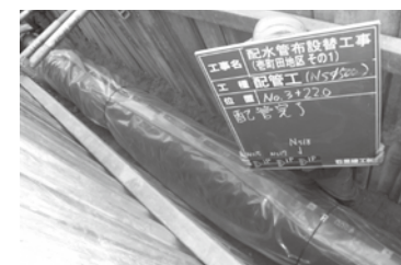
▲水道基幹管路耐震化工事
