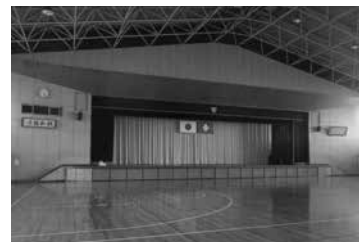
▲今後設置予定の体育館
