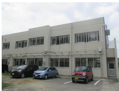
▲緑丘小学校屋内消火栓用配管設置
