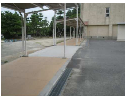
▲武豊小学校渡り廊下
